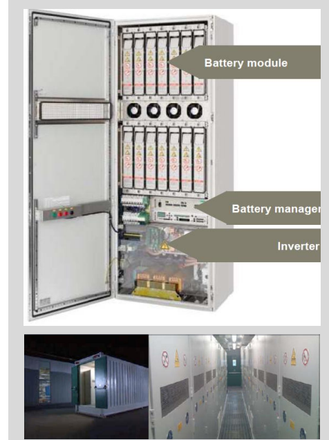
Li-Batterie-Speicher (-> 500 kWh, 1-2MVA)
