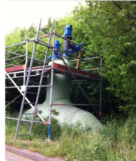
Sümpfungswasserleitung mit Entlüftungsventil Entnahmestelle für Probebetrieb (Schlauch)
