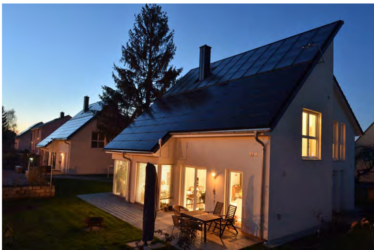
➤ Abb. 4: Die ersten beiden bewohnten energieautarken Einfamilienhäuser Europas in Freiberg/Sachsen, errichtet 2013 von der HELMA Eigenheimbau AG, Häuser, die zur Tankstelle werden Bis 2016: umfassende messtechnische Untersuchung durch die TU Bergakademie Freiberg. Diese bestätigt, dass die Berechnungen und Simulationen korrekt sind. Intelligente Eigenversorgung mit Wärme, Strom und Mobilität aus der Sonne.
