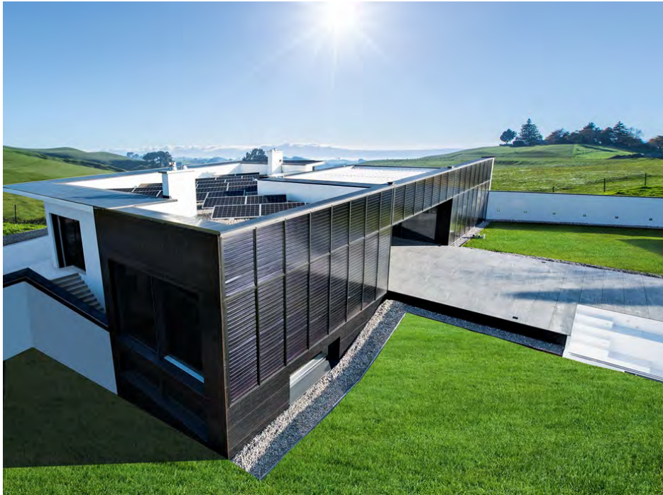
➤ Abb. 5: VitalSonnenhausPro der Firma Bauhütte Leitl-Werke GmbH: Das erste energieautarke – und barrierefreie – Gebäude Österreichs, Baujahr 2016 in Schwertberg/Oberösterreich. Bildquelle: Boris Maier/Bauhütte Leitl-Werke
