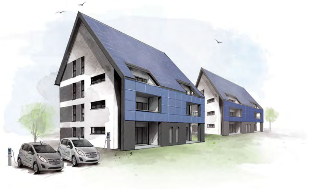
↗ Abb. 13: Das Modell überzeugt. In Cottbus: Zwei vermietete energieautarke Mehrfamilienhäuser mit je 7 Wohneinheiten, Baujahr 2018. Eine solare Deckung zwischen 65 und 77 Prozent für Strom und Wärme. Auch hier mieten die Bewohner die Wohnungen im Rahmen einer Pauschalmiets, die Wohnen, Wärme und Strom als Flatrate enthält.
