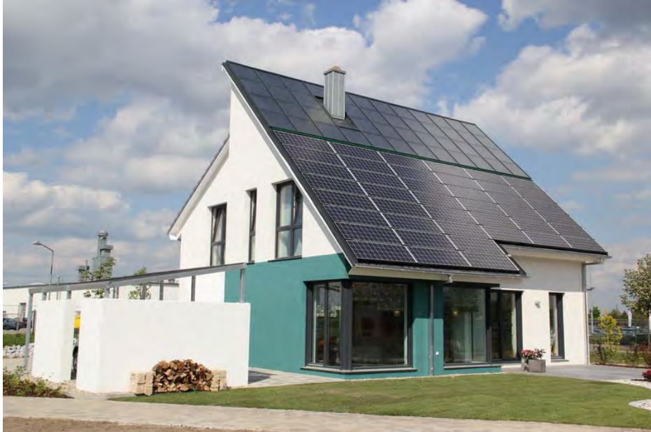
➤ Abb. 3: Erstes bezahlbares energieautarkes Eigenheim Europas als unbewohntes Musterhaus in Lehrte/Hannover von der HELMA Eigenheimbau AG Baujahr 2011. Es versorgt sich selbst mit Wärme, Strom und E-Mobilität: durch Solarthermie (mit Langzeitwärmespeicher), Photovoltaik (mit Akku) sowie etwas Biomasse. Primärenergiebedarf: 7 kWh/m 2 a.
